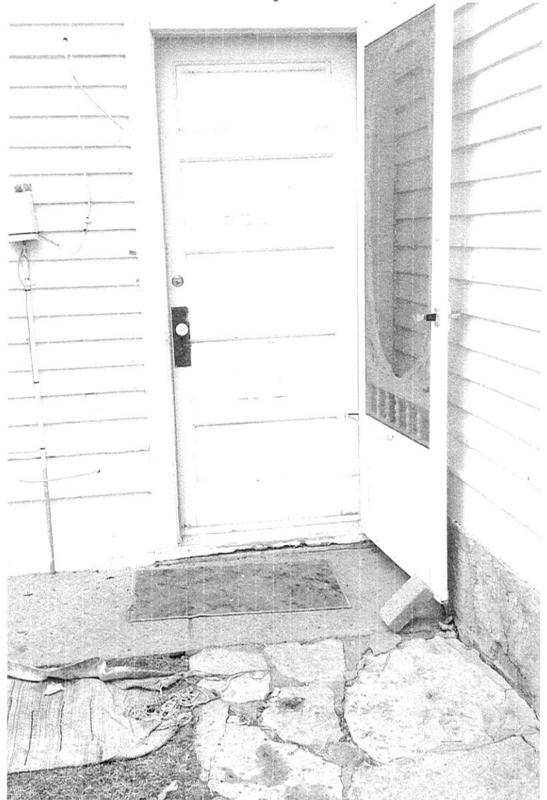
old garage door
